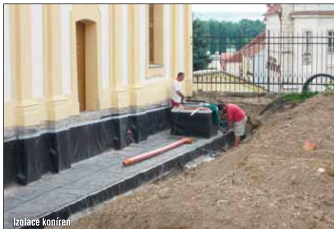
Pokládka hydroizolace u koníren
